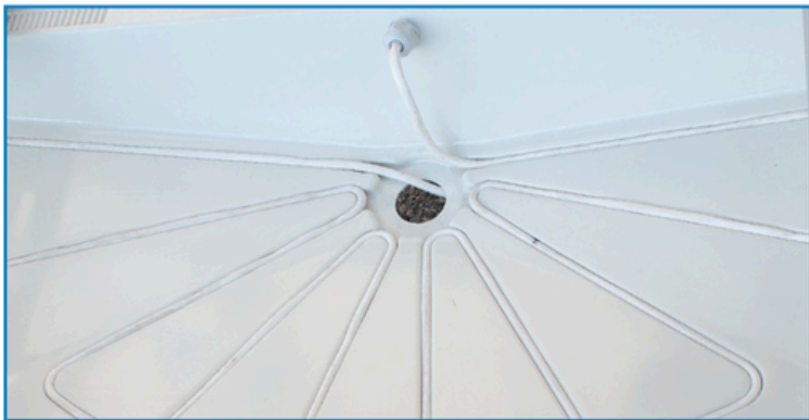
Tak wygląda prawidłowo zainstalowany przewód grzewczy.
