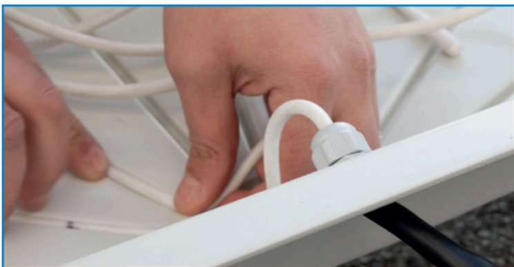
Rozprowadzić przewód równomiernie po całej tacy wciskając go w specjalne rowki ułożone w kształcie kwiatu.
